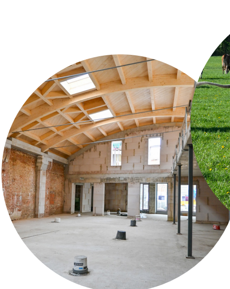
Abbildung 19: Blick in die Halle (Quelle: Bürgermolkerei Weimar)
