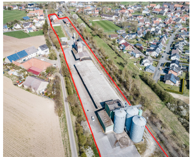
Abbildung 29: Altes AGRAVIS-Gelände in Willebadessen-Eissen (Quelle: M4 – Architekten)
